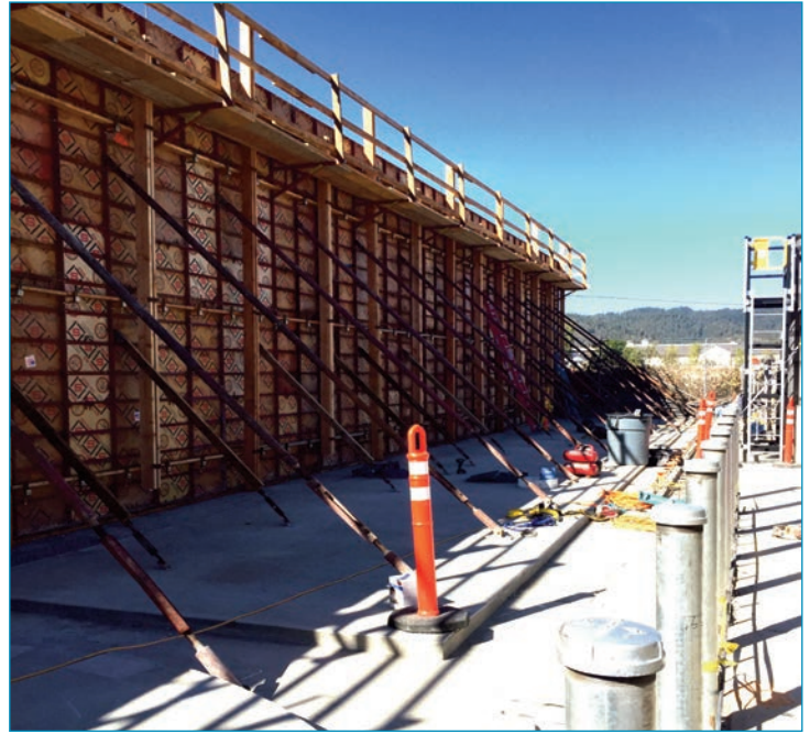
Firewall Forms Prior to Pour
